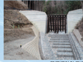
芦洞沢砂防堰堤
