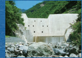
菟洞沢砂防堰堤
