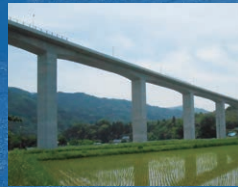
伊南バイパス4号橋
